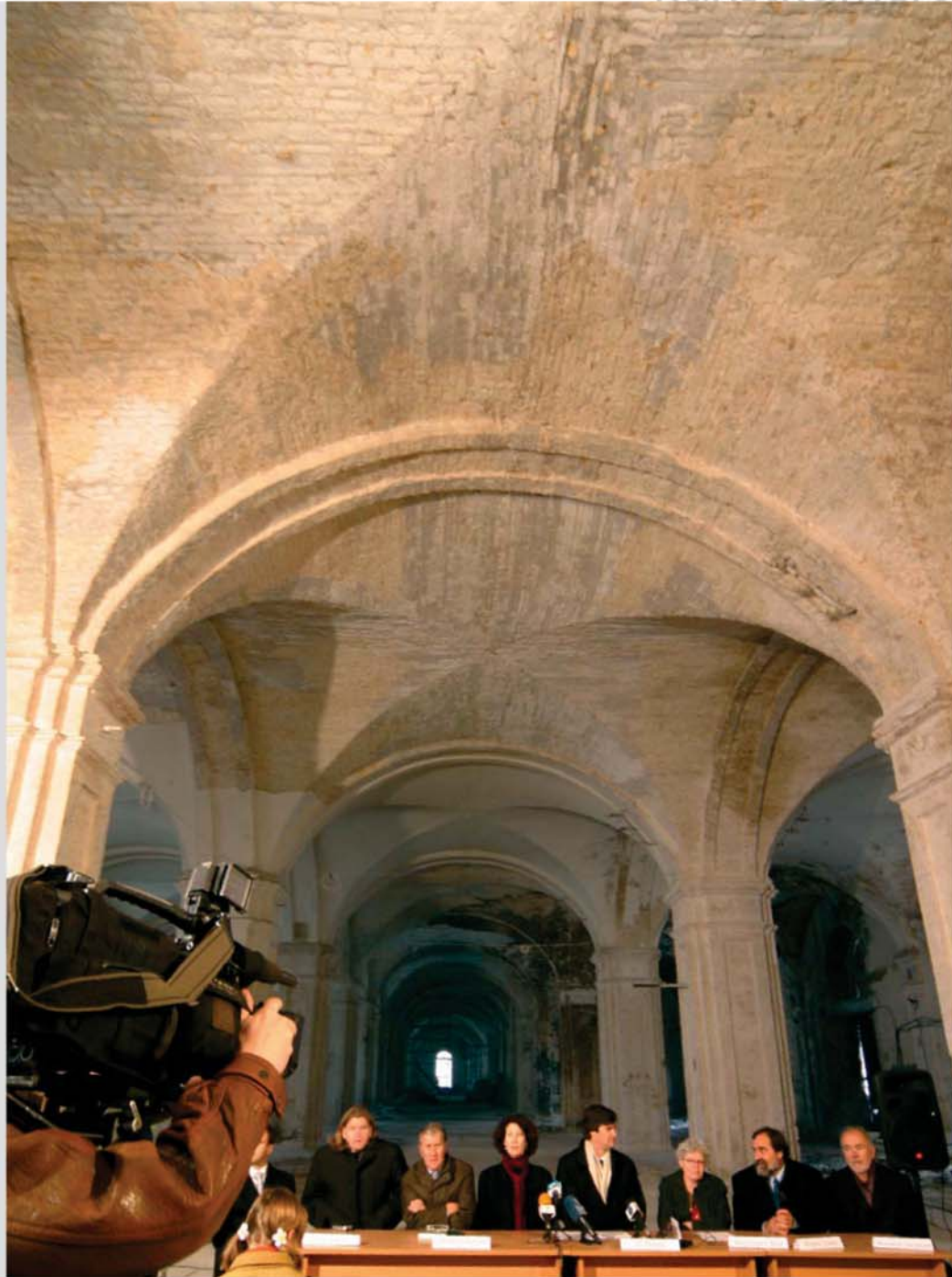
Склепіння Старого арсеналу
