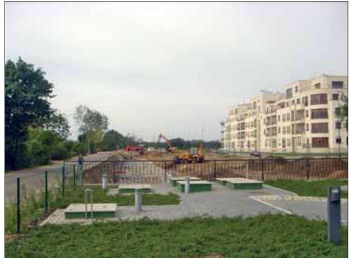
Realizacja parku i kanału w ulicy Klimczaka na odcinku Projektowana 4 – Królowej Marysieńki – widok z pompowni wód deszczowych PD1.
