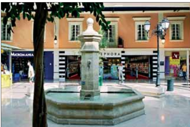
Centrum handlowe Auchan w Avignon.
