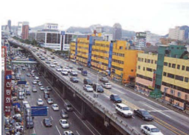
PRZED – Potok w Seulu zabudowany autostradą
